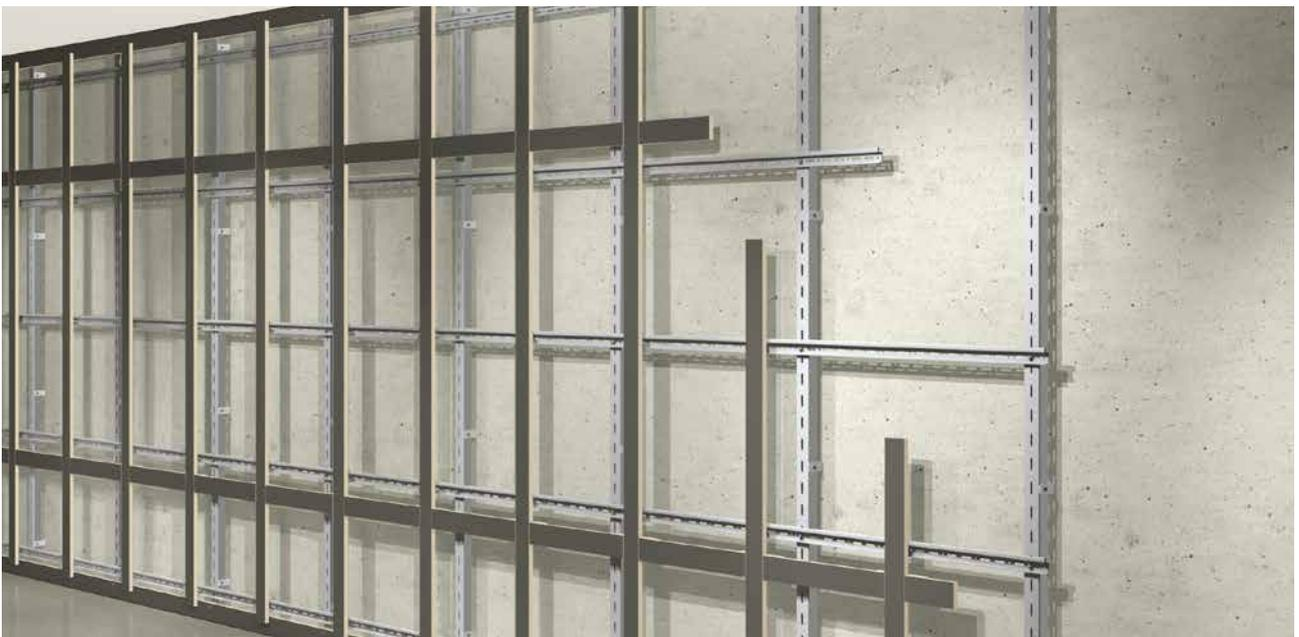
Zur Aufnahme der Paneele vorbereitete Unterkonstruktion
