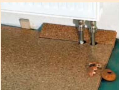
**4** Bei Heizungsrohrdurchbrüchen die Diele am Stoß aus- klicken und mit Heizkörperrosetten abdecken.
