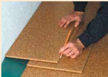
**6** Einpassen der letzten Dielenreihe: Legen Sie exakt auf die zuletzt verlegte Dielenreihe die nachzusägende Diele. Dann zeichnen Sie mit Hilfe einer weiteren Diele den Längsschnitt an.
