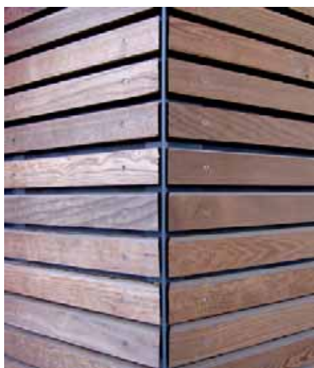
Fassaden Serie Rombo Exzellent 27x68 mm TMTEsche 3 Jahre bewittert
