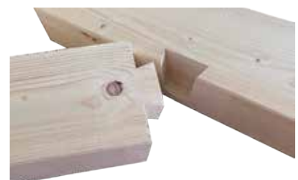
Schwalbenschwanz-Verbindung mit Zulassung
