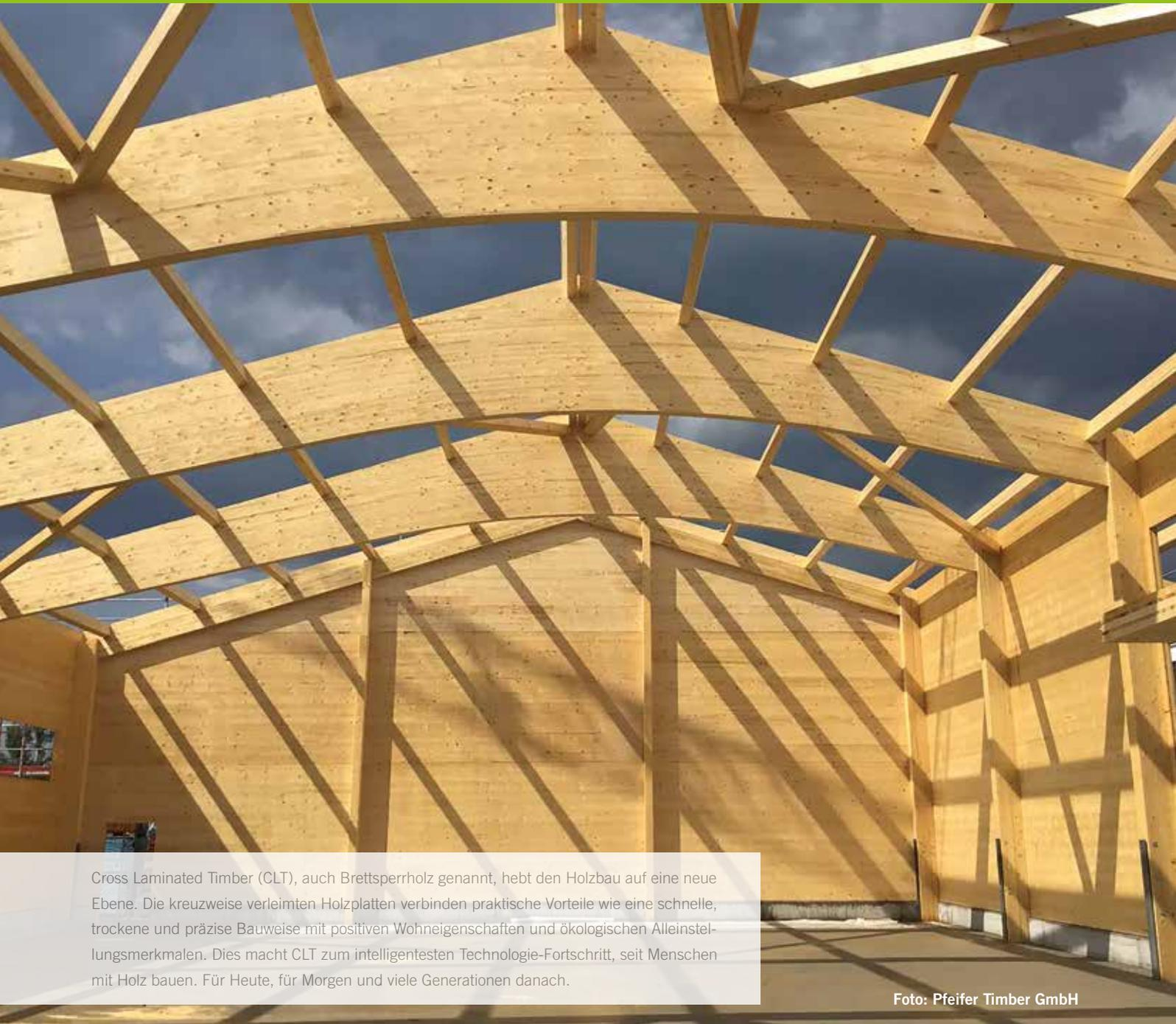
Cross Laminated Timber (CLT), auch Brettsperrholz genannt, hebt den Holzbau auf eine neue Ebene. Die kreuzweise verleimten Holzplatten verbinden praktische Vorteile wie eine schnelle, trockene und präzise Bauweise mit positiven Wohneigenschaften und ökologischen Alleinstellungsmerkmalen. Dies macht CLT zum intelligentesten Technologie-Fortschritt, seit Menschen mit Holz bauen. Für Heute, für Morgen und viele Generationen danach.
