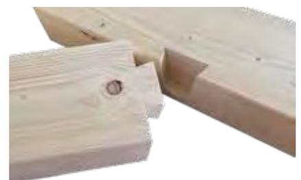
Schwalbenschwanz-Verbindung mit Zulassung
