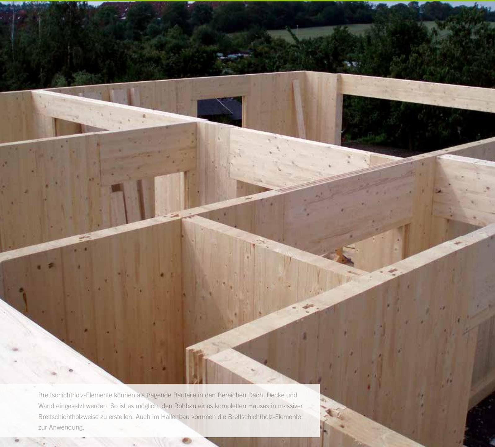
Brettschichtholz-Elemente können als tragende Bauteile in den Bereichen Dach, Decke und Wand eingesetzt werden. So ist es möglich, den Rohbau eines kompletten Hauses in massiver Brettschichtholzweise zu erstellen. Auch im Hallenbau kommen die Brettschichtholz-Elemente zur Anwendung.
