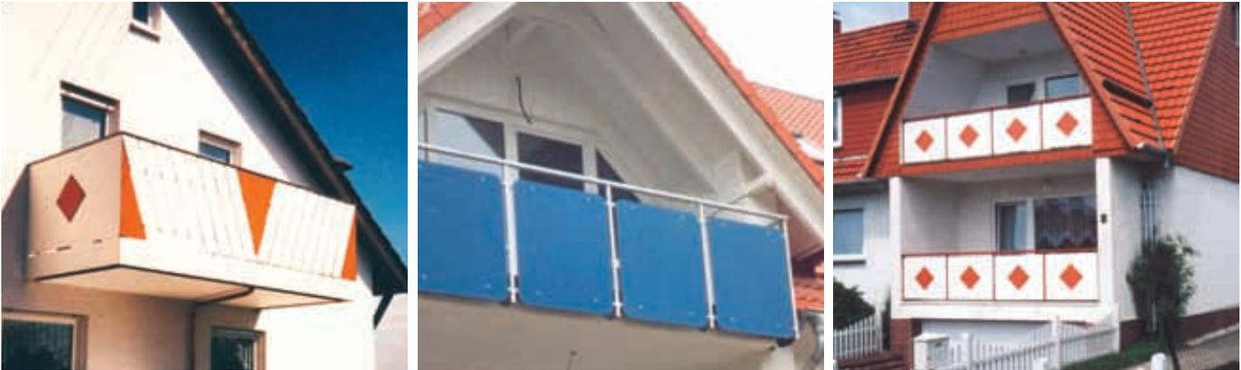
ComPlan ist eine absolut witterungsfeste Platte für die Außenbekleidung von Wohnungs- und Wirtschaftsbauten. Die Platte hat einen Kraftpapierkern, die Oberflächen sind mit Phenol- bzw. Melaminformaldehydharzen imprägniert. Die Platten erhalten dadurch eine besondere Widerstandsfähigkeit gegen Sonneneinstrahlung, Temperaturschwankungen und Feuchtigkeitseinflüssen.
