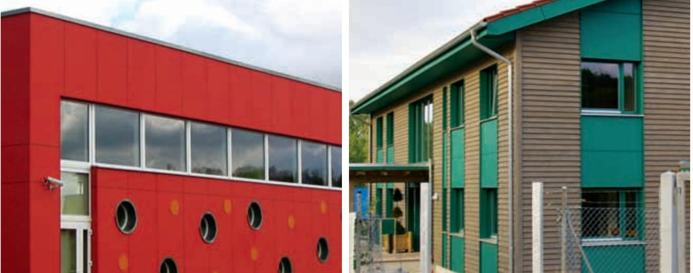
Ab sofort ist dieses bewährte Produkt in neuer Qualität, mit einer zweikomponentigen Farblackierung erhältlich. Diese neue Oberfläche weißt eine hohe chemische und mechanische Beständigkeit auf. Ihre körnige Struktur reduziert die Verunreinigung durch Witterungseinflüsse und ist kratzresistenter.
