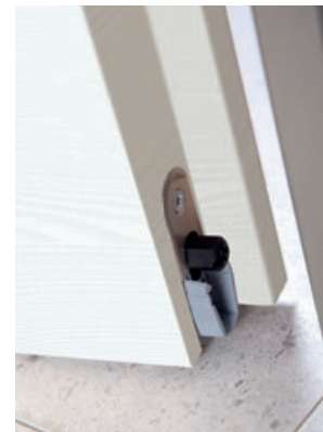
Standardausstattung bei Schallschutztüren: mechanisch absenkbare Bodendichtung
