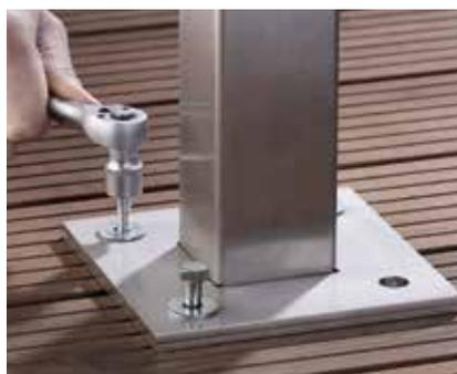
Pfosten ausrichten und montieren.
