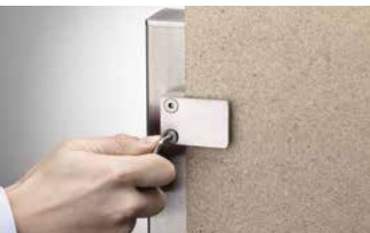
Holzplatten als Montage-Hilfe an Pfosten montieren.
