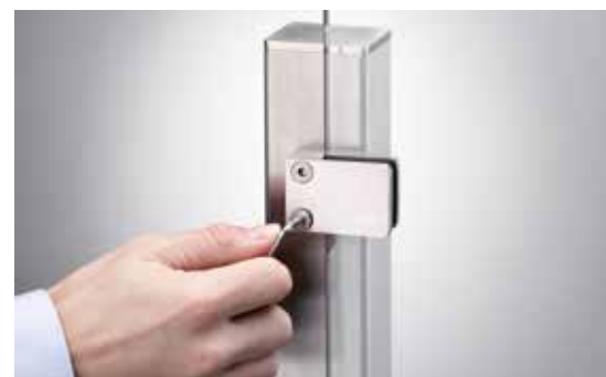
Holzplatten entfernen und Scheiben an Pfosten montieren. Fertig!
