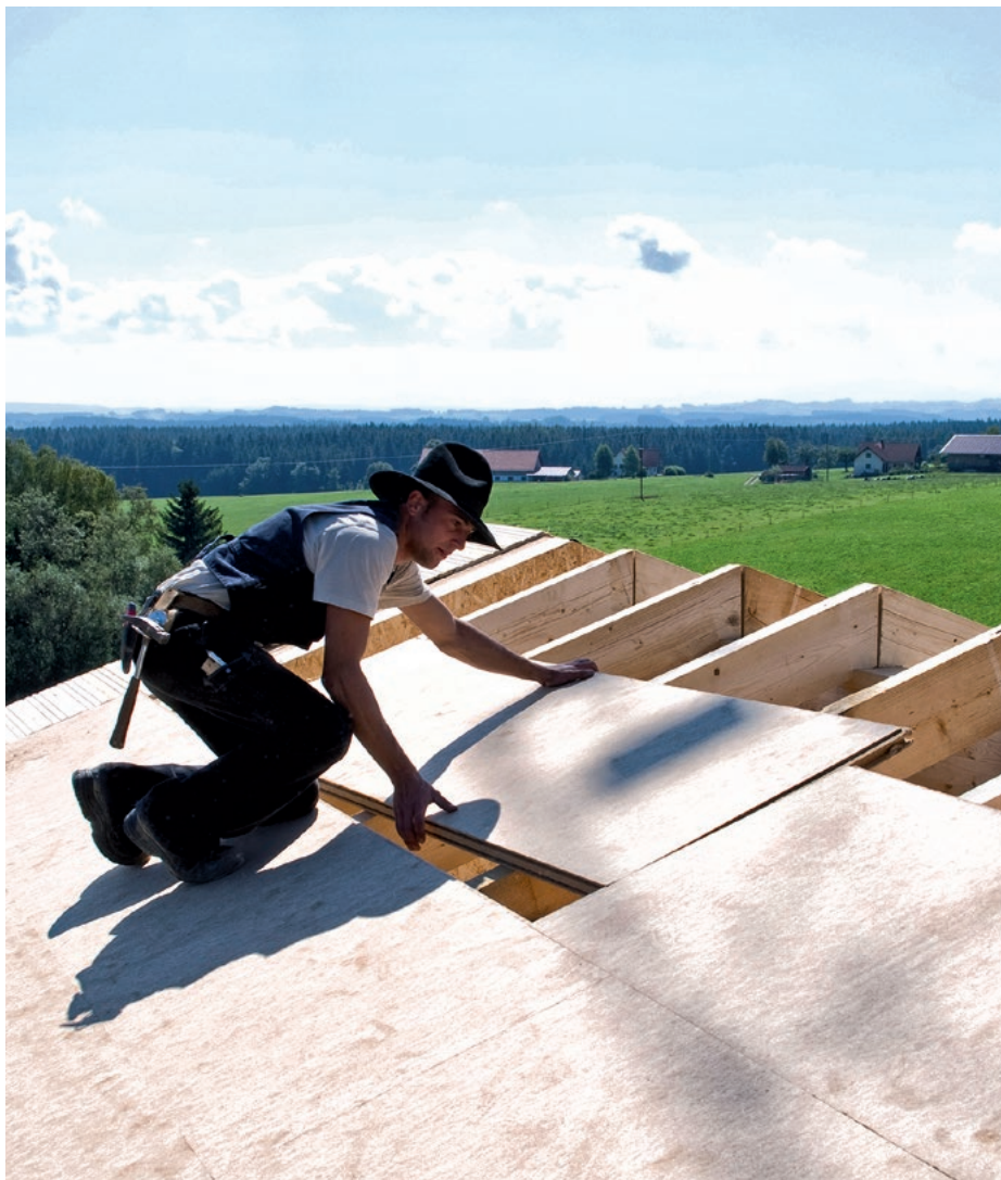
Optimaler Schutz und vollkommen natürlich: Holzfaserdämmplatten auf dem Dach.
