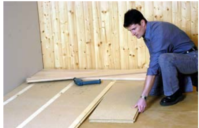
△ Schnell und einfach verlegt für optimalen Trittschall unter Massivböden.
