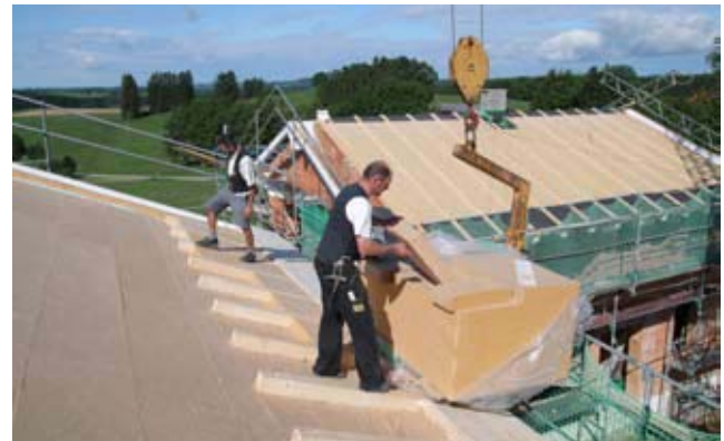
△ Verlegung der handlichen, stabilen PAVATHERM-Holzfaserdämmplatten auf die Sparren.
