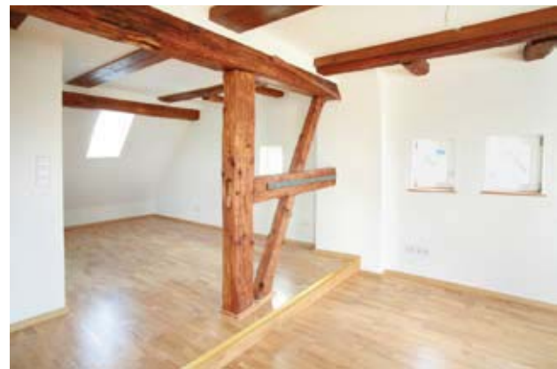
△ PAVADENTRO, damit das Klima nach der Sanierung funktioniert.
