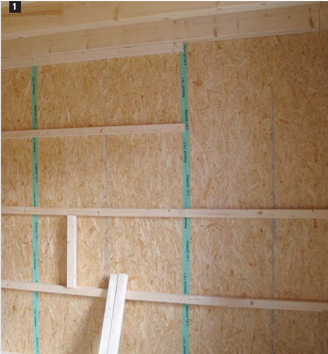
1 Luftdichte Verklebung von OSB-Platten mit Ampacoll® I.N.T.
