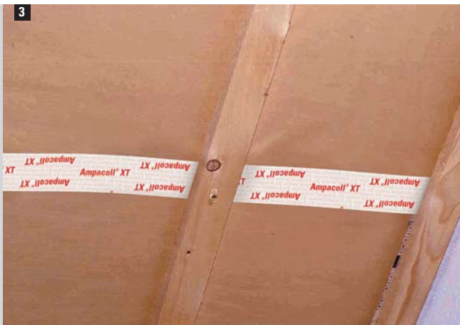
3 Sisalex® 500, Überlappungsverklebung mit Ampacoll® XT.
