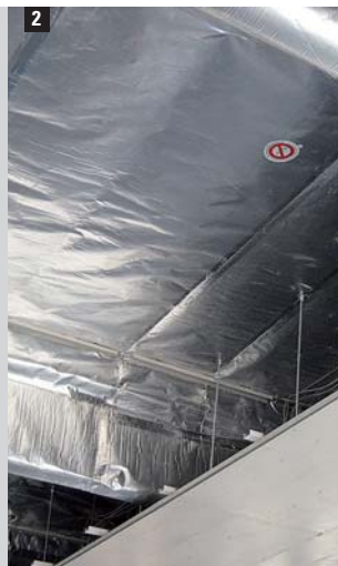
1/2 Einbau einer Dampfsperre und Luftdichtung Sisalex® 514 in einem Hallenbad.
