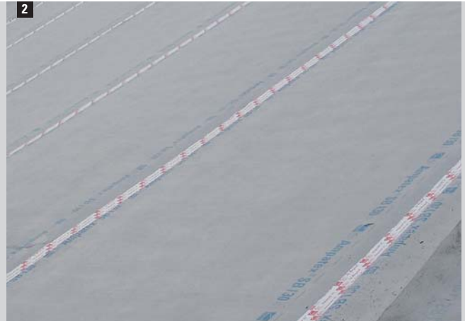
2 Ampatex® SB 130, Schalungsbahn, Überlappungsverklebung mit Ampacoll® XT
