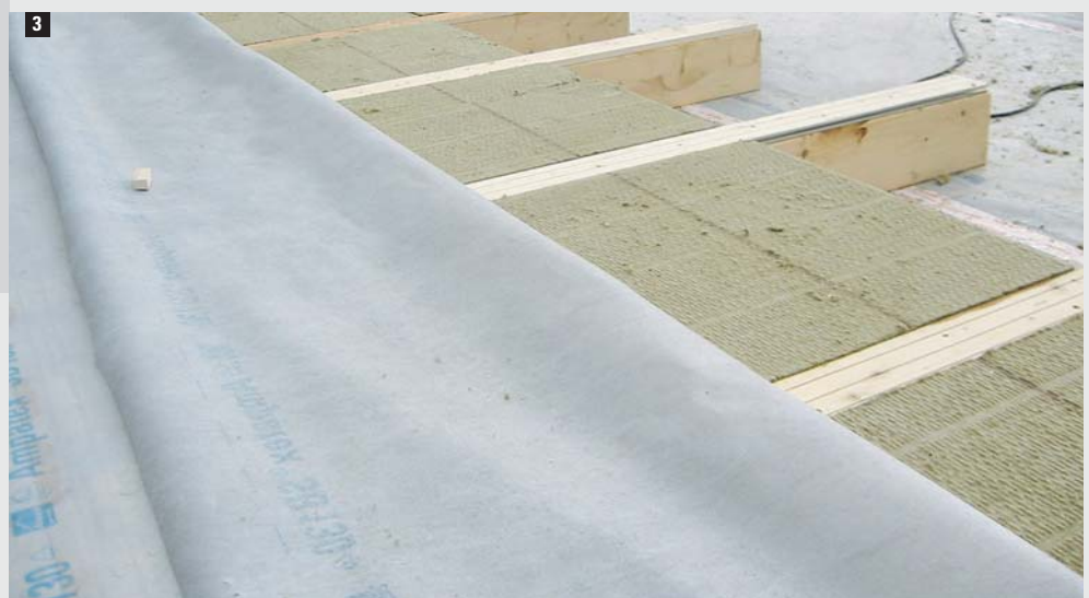
1-3 Aufsparrendämmung mit Ampatex® SB 130. Überlappungsverklebung mit Ampacoll® XT.
