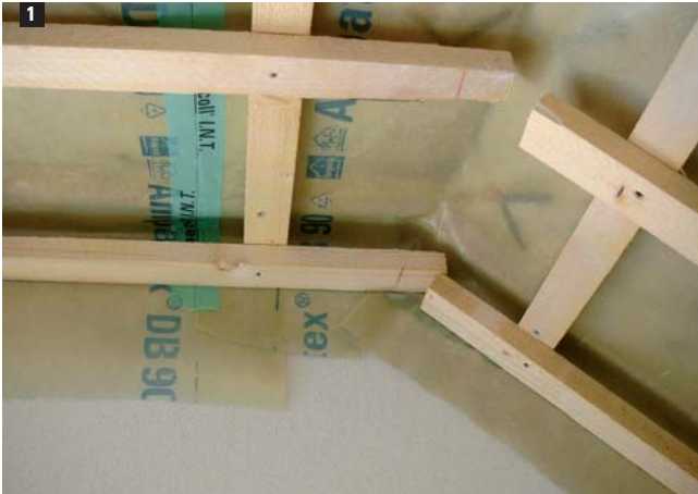
1 Ampatex® DB 90, Überlappungsverklebung mit Ampacoll® I.N.T.
