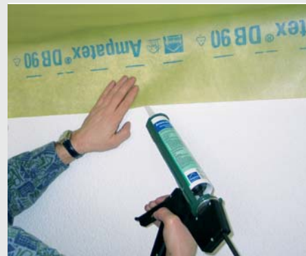
2 Ampatex® SB 130, Schalungsbahn, Überlappungsverklebung mit Ampacoll® XT
