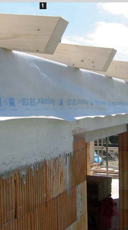
1-3 Aufsparrendämmung mit Ampatex® SB 130. Überlappungsverklebung mit Ampacoll® XT.
