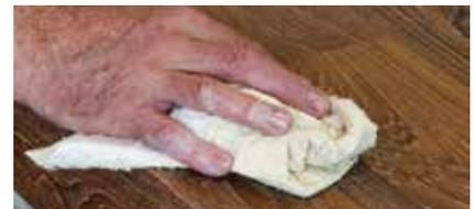
1. **Tragen** Sie eine kleine Menge **RMC Oil Plus 2C auf** und verteilen Sie es mit einem Tuch oder einer Poliermaschine mit dünnen beigen Pad. Behandeln sie jeweils einen Bereich von 5 - 10 m<sup>2</sup>.
